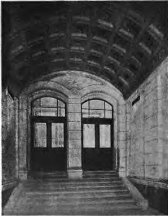
Abb. 148. Eingangshalle im Gerichtsgebäude zu Salzburg, aus vorgeformten Betonkassetten ohne durchgehende Rüstung hergestellt. — Arch. A. v. Wielemans.
